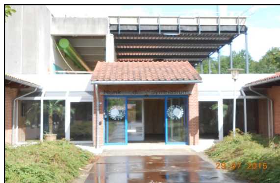
Nyt indgangsparti under opførelse
